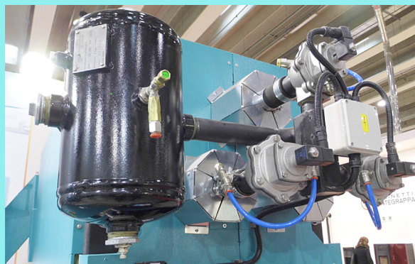
Saspiestā gaisa tvertne automātiskai tīrīšanai. Automātiska siltummaiņa pneimatiskā tīrīšana, lai samazinātu gala lietotāja iesaistīšanos katla tīrīšanā.
